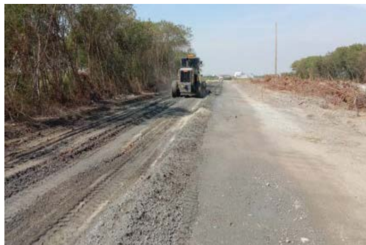
ถนนเข้าพื้นที่ก่อสร้างด้านทิศใต้
