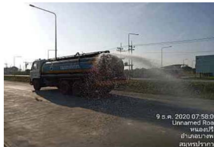
ฉีดน้ำพื้นที่ถนน บริเวณรถบรรทุกดินโครงการวังผ่าน เพื่อลดฝุ่นละออง
