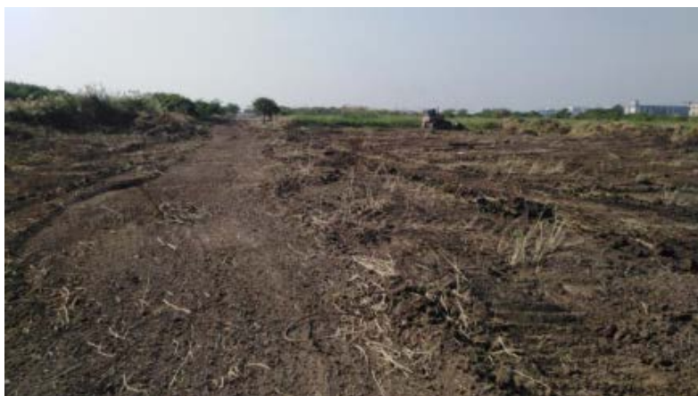
ทางป่าปรับเปลี่ยนพื้นที่ก่อสร้าง : ส่วนเหนือ
