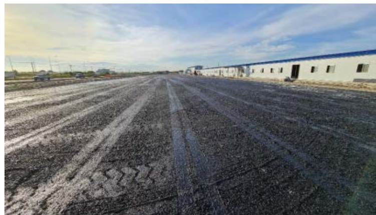
งานปรับพื้นที่ลานจอดรถ
