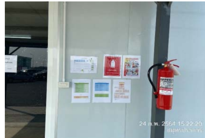
ติดป้ายถังดับเพลิงและวิธีการใช้งานที่สำนักงานโครงการ
