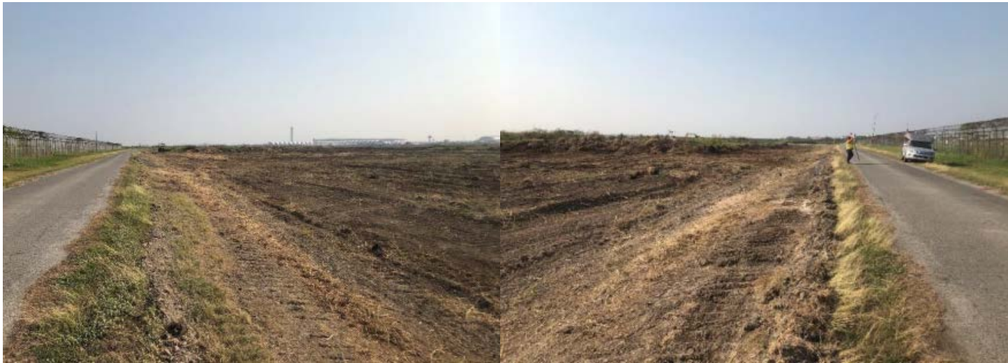
งานเคลียร์พื้นที่ บริเวณอาคาร ARFF
