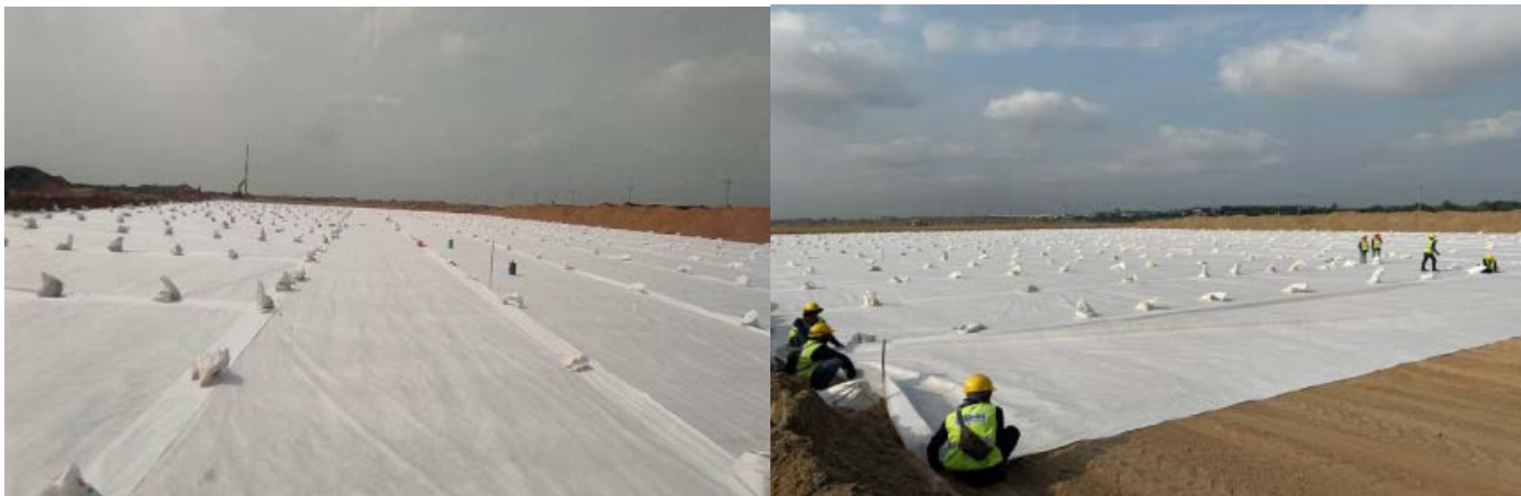
งานปูผ้า Geotextile
