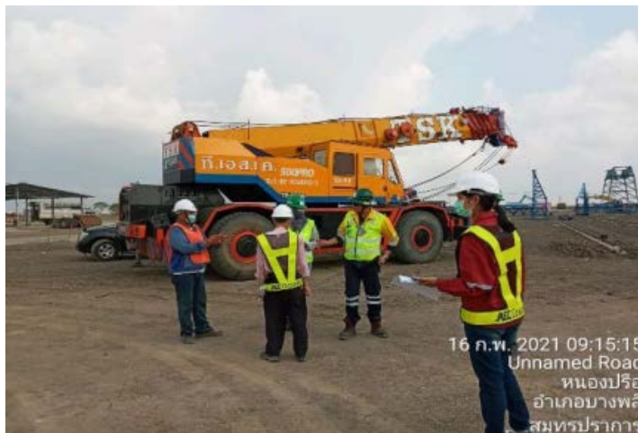
ตรวจสอบเครนก่อนปฏิบัติงาน
