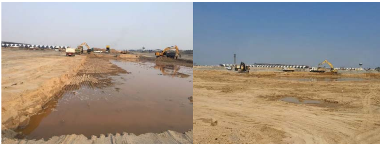
งานปรับดิน บริเวณทางวิ่งเส้นที่ 3
