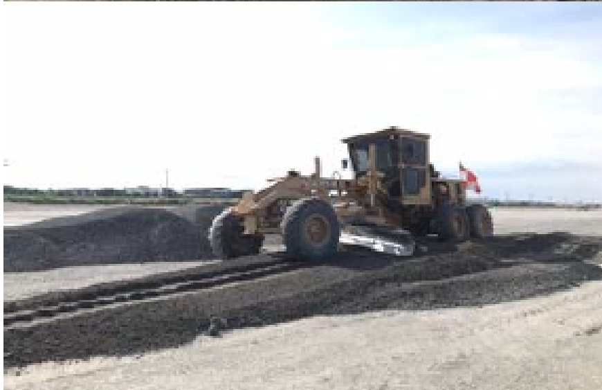
งาน Compacted existing subgrade CBR 6% : South
