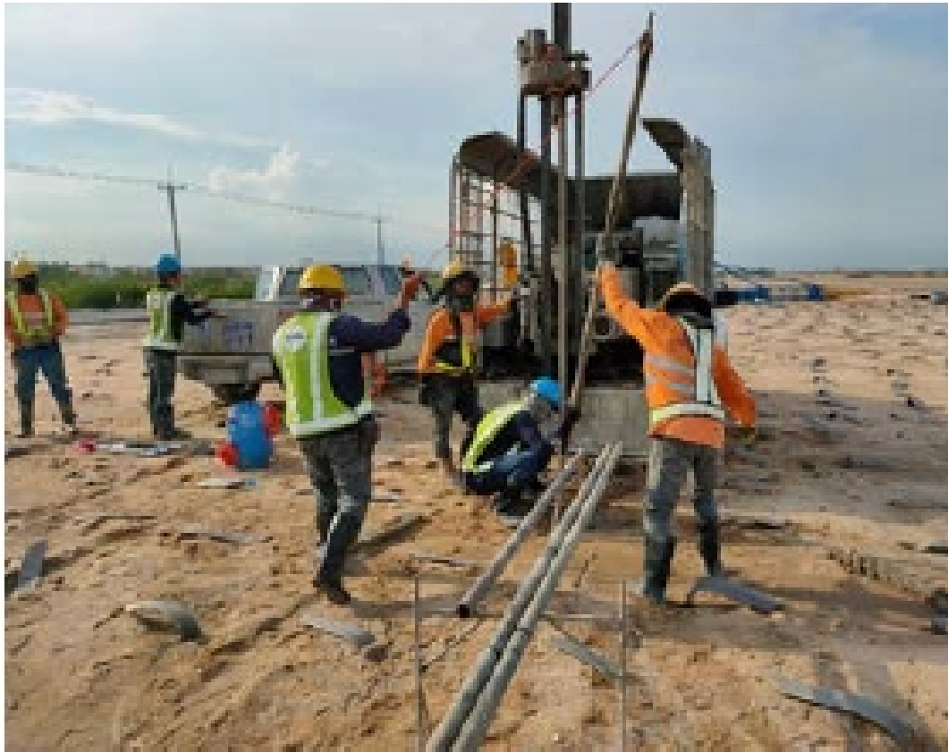
งาน Installation of monitoring Instrumentation
